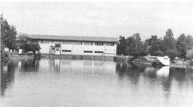
Nach vierzig Betriebsjahren wird das Kraftwerk Wildegg-Brugg bei Villnachern einer technischen Ertüchtigung unterzogen
