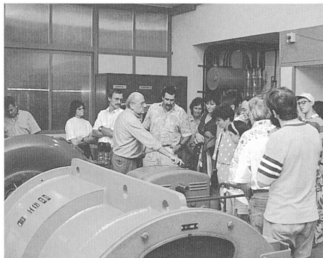
Im Kraftwerk Frauenkirch gab es neben den heute im Betrieb stehenden Maschineneinheiten (Bild) auch solche aus dem Jahr 1894 zu sehen
