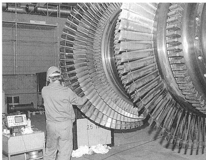
Nach mehr als 22 Betriebsjahren befinden sich die Turbinen des Kernkraftwerks Beznau in einem ausgezeichneten Zustand. Ein Mitarbeiter der Erbauerfirma Brown Boveri (ABB) nimmt Prüfungen an einer Niederdruckturbine vor
