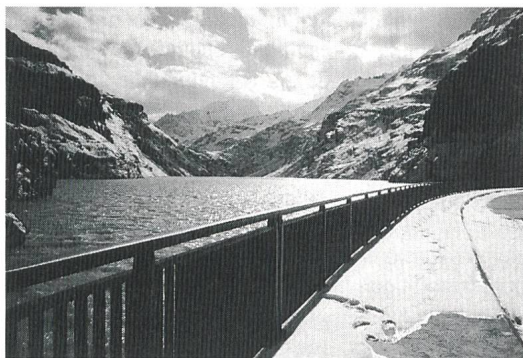
Speichersee Mauvoisin (VS): erhöhtes Rückhaltevermögen nach Staumauererhöhung
