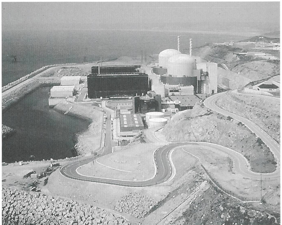
Bild 3 Kernkraftwerk Flamenville, Normandie: 2 Blöcke mit insgesamt 2660 MW
