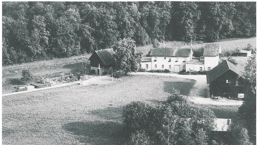
Bild 1 Das Stromhaus Burenwisen bei Glattfelden (ZH), zwischen der SBB-Station und der Glatt
