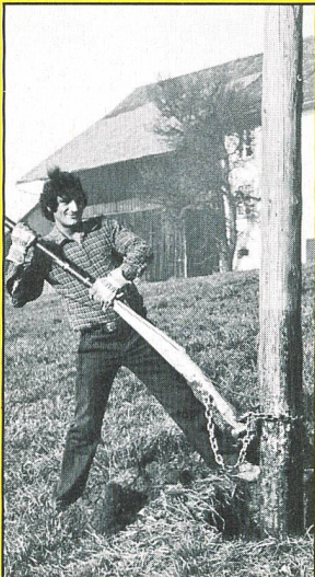
Nachimprägnierung von Holzmasten
