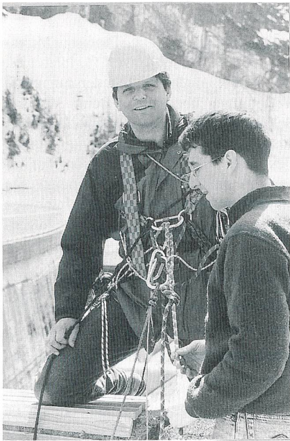
Dr. Adrien Cornaz (links) und Bruno Hubler (rechts) bei der Installation der Messeinrichtungen an der Staumauer Gigerwald
