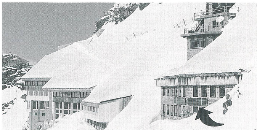
Bild 1 Flugaufnahme der höchstgelegenen netzgekoppelten Photovoltaikanlage der Welt, die seit Oktober 1993 an der Fassade der hochalpinen Forschungsstation Jungfraujoch in Betrieb steht. Links im Bild erkennt man das Restaurant Jungfraujoch
