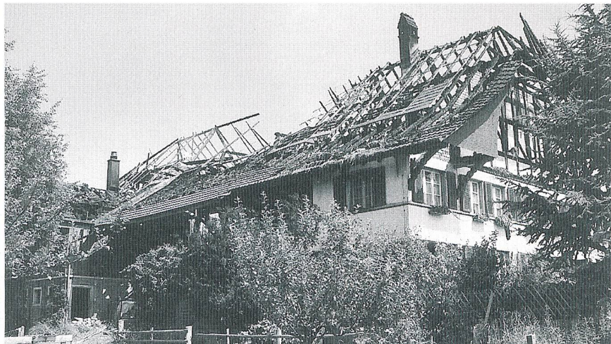
Weitgehende Zerstörung des Bauernhauses
