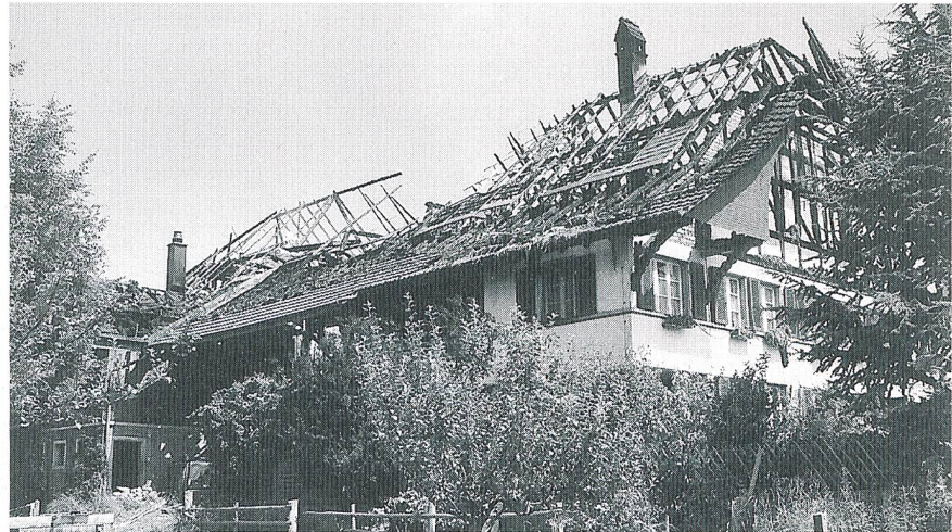
Weitgehende Zerstörung des Bauernhauses
