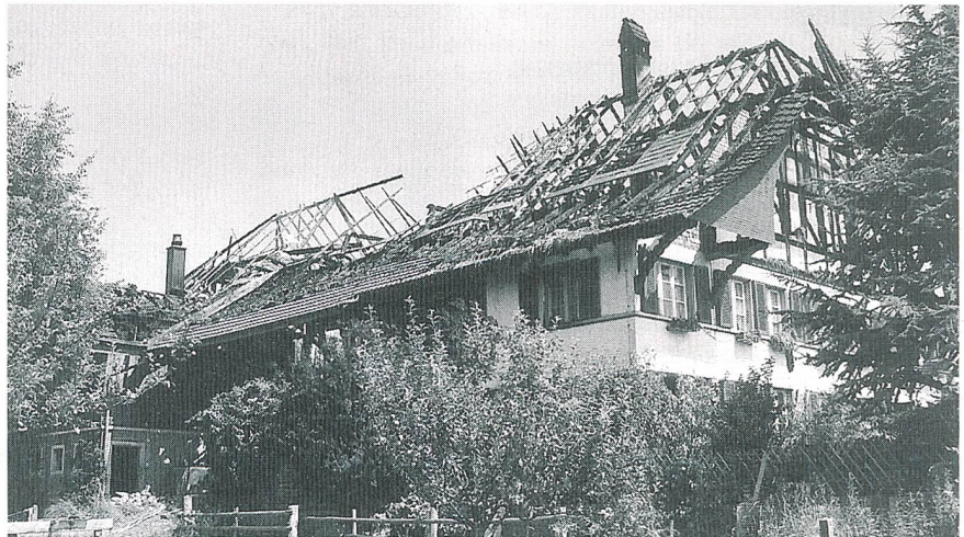
Destruction considérable de la ferme
