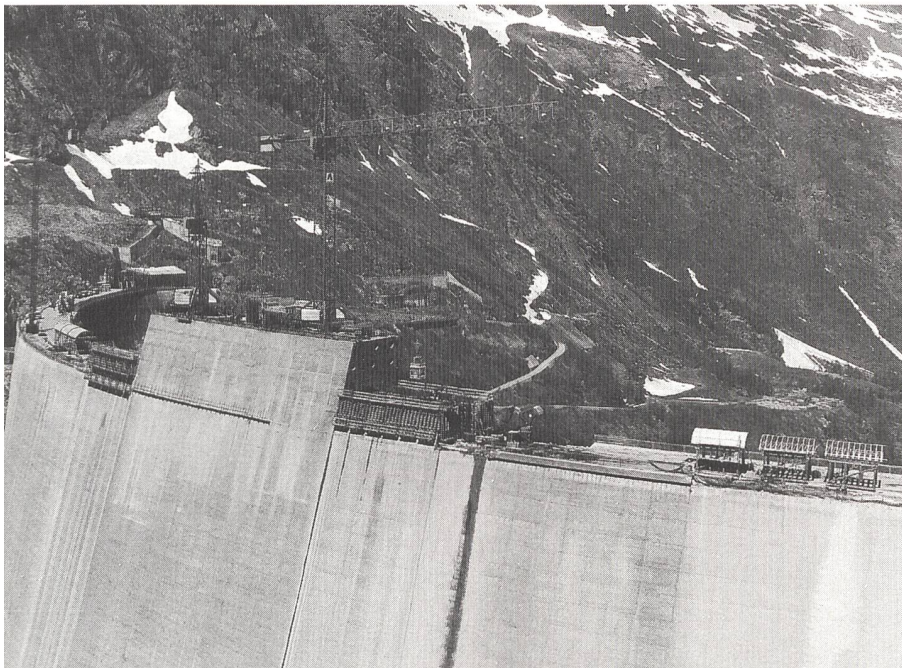
La surélévation du barrage de Mauvoisin entre 1989 et 1992. La décision d'augmenter la puissance de 550 MW - Mauvoisin II - a été ajournée.
