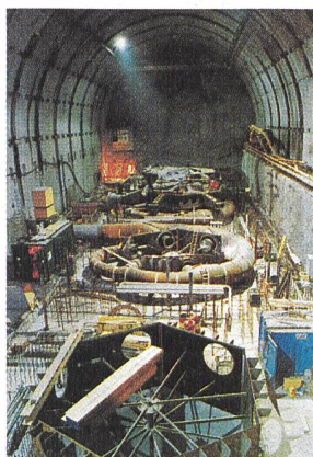
Montage der vier Maschinengruppen in der Kavernenzentrale Amsteg (4 sechsdüssige Pelton-turbinen mit je 40 MW).
