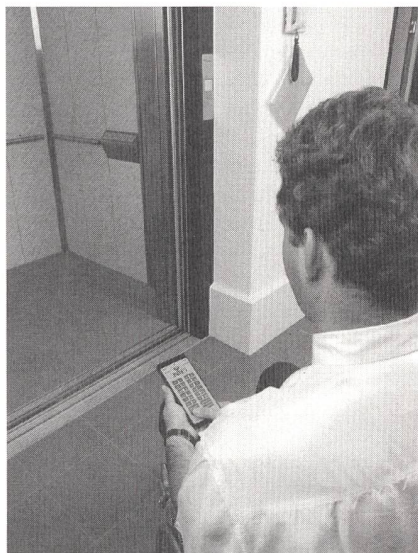
Bild 2 Als Sensoren dienen beim EIB-System auch Fernsteuerungen.
