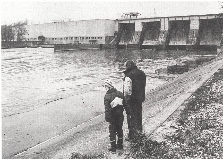
L'usine hydroélectrique de Verbois a subi des dégâts importants lors de l'incendie du 9 février.
