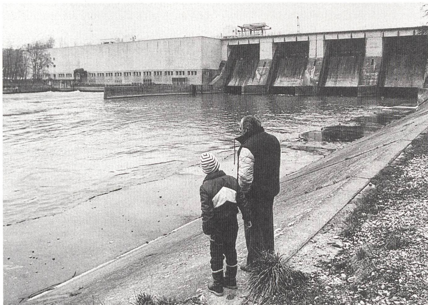
L'usine hydroélectrique de Verbois a subi des dégâts importants lors de l'incendie du 9 février.
