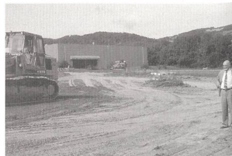
Zwilag-Geschäftsführer Dr. Hans-Rudolf Lutz (links) und sein Stellvertreter Alex Streichenberg (rechts) beim Baubeginn des Zwischenlagers für radioaktive Abfälle am 26. August 1996.
