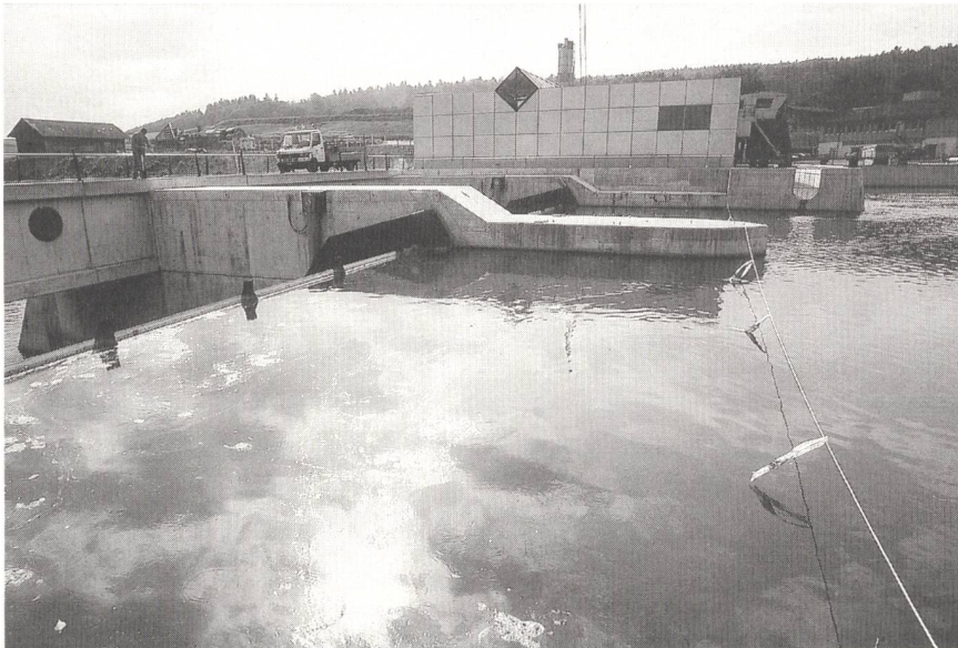
Nach vier Jahren Bauzeit wird nun im neuen Aarekraftwerk der EWW Strom produziert.
