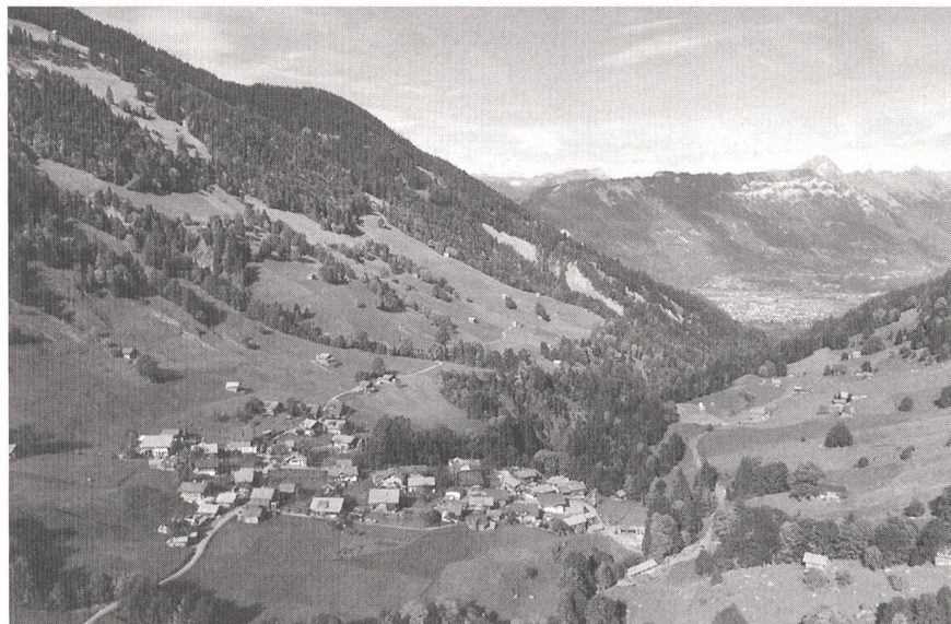
Im Saxetental, 10 km von Interlaken entfernt, wird ab 1998 mit einer Trinkwasserturbinierung zusätzlicher Strom für das Versorgungsgebiet der Industriellen Betriebe Interlaken produziert.
