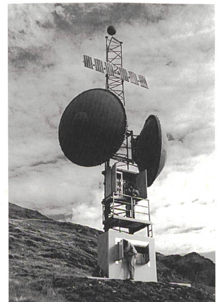
Bild 1 Stromversorgung eines isolierten Standortes
