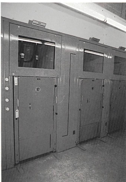
Bild 1 Front TS-Falera/Curnius; nachträglich ein-gebaute Längstrennung
