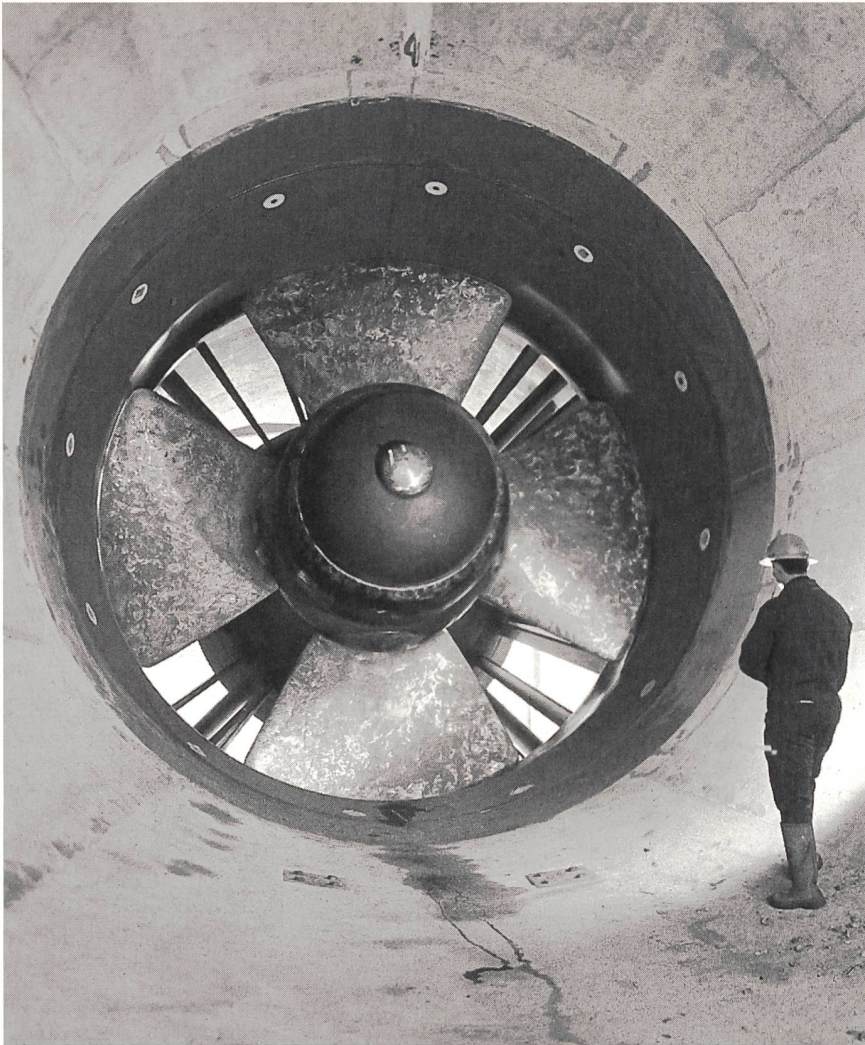
Bild 2 Vierflügelige Kaplan-Rohrturbine mit 5,35 m Laufraddurchmesser (Meereseite, Bild EdF). «C'est impressionnant», sprach General de Gaulle anlässlich der Einweihung am 26. November 1966.
