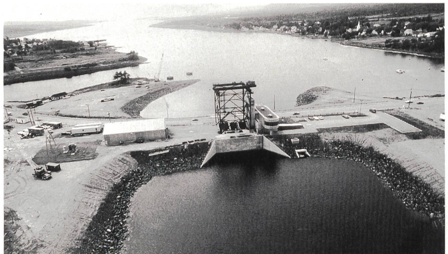
Bild 3 Kraftwerkgebäude Annapolis Royal in einem Seitenarm der Bay of Fundy: kompakt und weitgehend unter Wasser (Bild Sulzer Hydro).
