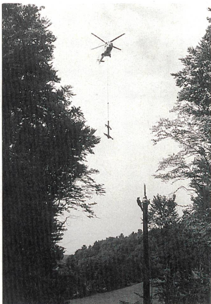
Bild 1 3,3 Tonnen kommen durch die Luft.
