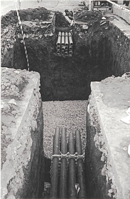
Bild 6 Bau des Trassees für das Primärnetz mit vorgesehenem Zugschacht
