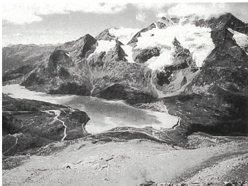
Der Lago-Bianco-Stausee am Berninapass der Kraftwerke Brusio.
