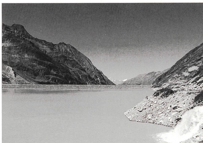
Die EGL besitzt neu 50% am Kapital der Kraftwerke Mattmark. (Bild: Stausee Mattmark)
