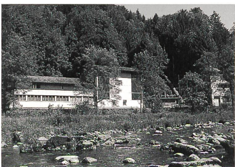
Der Anteil der erneuerbaren Energien stammt vorwiegend aus den EKZ-eigenen Wasserkraftwerken Waldhalde (Bild) und Dietikon.
