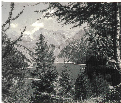
Der Stausee Luzzone der Blenio Kraftwerke AG: Sie weisen 1996 Jahreskosten von 38,7 Mio. Franken aus, das sind 4% weniger als im Vorjahr.
