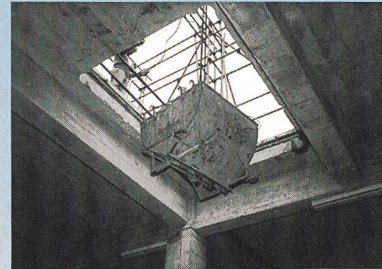
9 Evacuation des gravats par un accès créé à cet effet.
