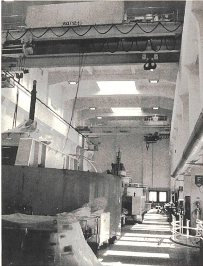
3 La première opération a consisté à remettre en état le double pont roulant, indispensable pour démonter les groupes en vue d'une décontamination en profondeur.
