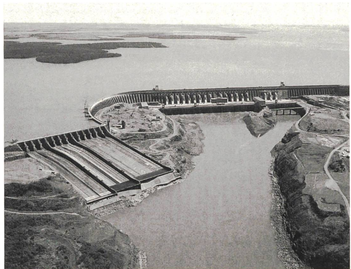
Grösstes Wasserkraftwerk der Welt (Brasilien/Paraguay): Itaipu (12 000 MW Leistung; Photo Itaipu Binacional).
