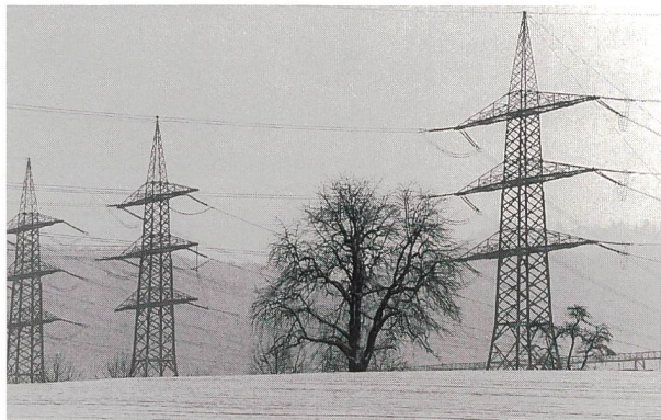
Überlandleitungen: Installationen zur sicheren Stromversorgung.
