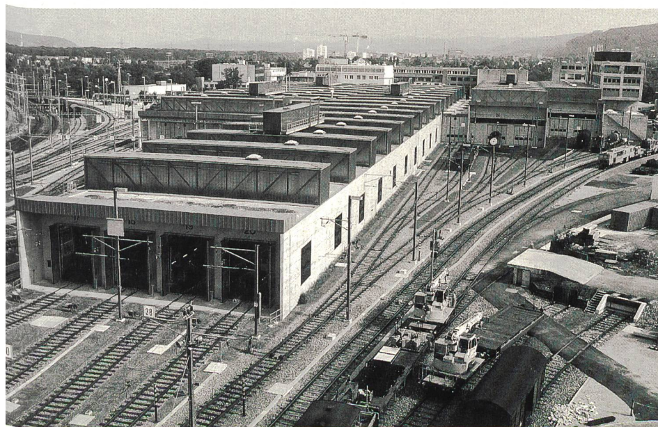
Bild 1 Aussenansicht des neuen Lokdepots Basel für die «Bahn 2000» mit Betriebsremise (links oben), Pendelzughalle (Vordergrund), Werkstattremise und Dieselwerkstätte sowie Bürogebäude (rechts oben). Dieser Gebäudekomplex weist nicht nur in bahntechnischer Hinsicht ein zukunftsgerichtetes Konzept auf, sondern verfügt vor allem auch bezüglich der Beleuchtungstechnik, das heisst bei der Lichtsteuerung, über eine unkonventionelle Lösung. (Fotos: Carlo Gavazzi AG)
