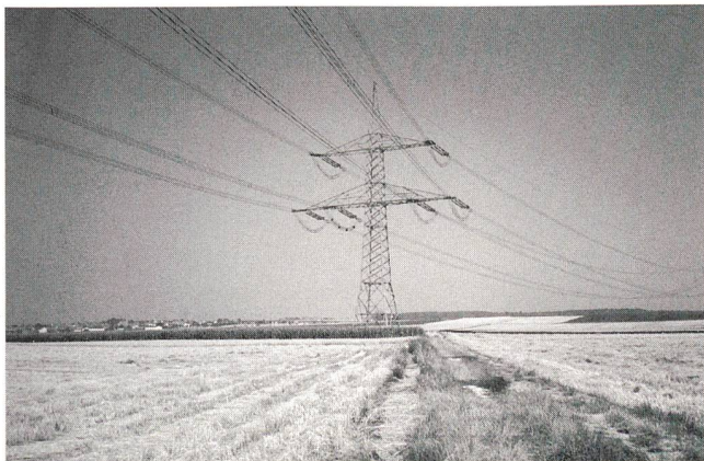
Verhandelter Netzzugang mit «Netzzugangsalternative»: Hochspannungsleitung in Norddeutschland.
