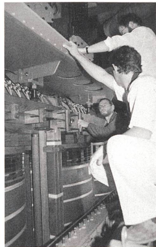
Figura 3 Ispezione del trasformatore.
