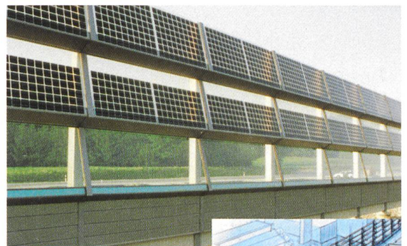
Hochabsorbierende Schallschutzwand mit Grosslaminaten von Creaglas und Zellen von Siemens Solar. Werkbild FabriSolar AG
