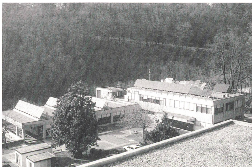
Bild 1 10-kW p -m-Si-Anlage (1982) und 4-kW-a-Si-Anlage (1988).
