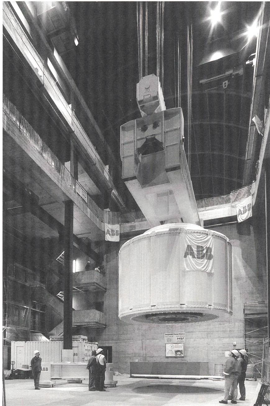
Cleuson-Dixence: Le premier rotor a été mis en place le 18 août 1997 dans le groupe 3.
