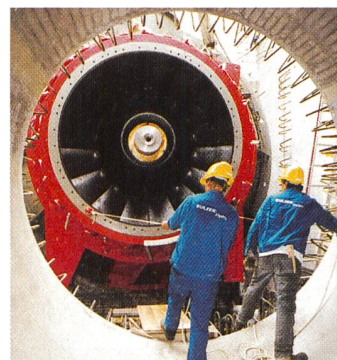
Einbau der Rohrturbine für das Reusskraftwerk Mühlenplatz in Luzern.
