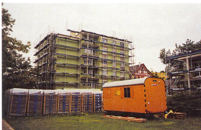
«Energie 2000»: energetische Sanierung von Gebäuden.
