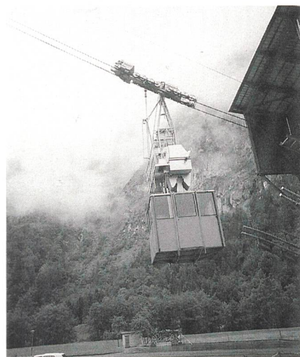
Die technisch erneuerte Werkseilbahn des KLL steht während den Sommermonaten auch dem Publikum offen und verkehrt nach regelmässigem Fahrplan.
