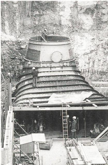
Montage der Saugrohrpanzerung für die neue Turbine 4.
