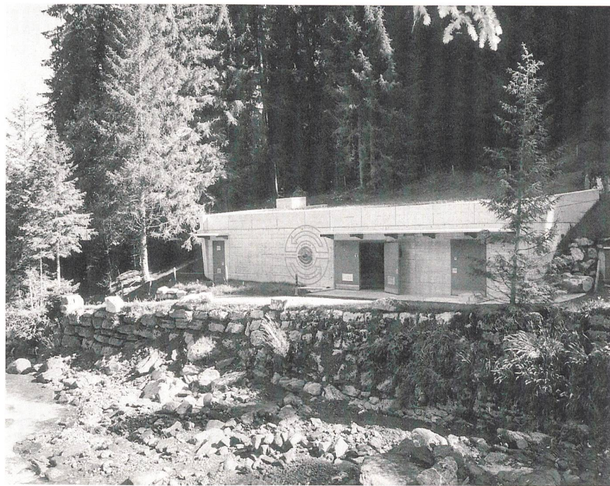
Die Zentrale Geissbrunnen im Saxettal: Das Trinkwasser aus den Quellen auf Alp Nessleren wird im Reservoir Stalden gesammelt und in einer 1. Stufe in der Zentrale turbinieren.
