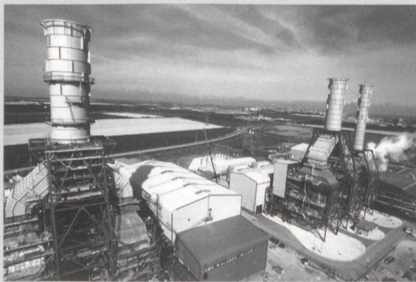
Kombikraftwerk South Humber Bank (England, Bild ABB).
