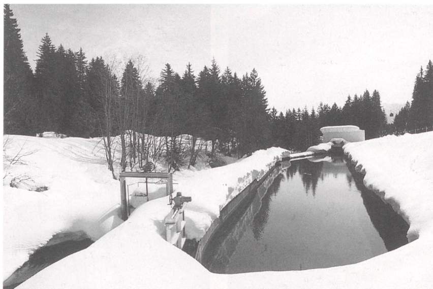
Bild 7 Tief eingeschnitten bieten die Anlagen der Wasserfassung ein besonderes Bild.
