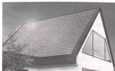
Das System vereint Dacheindeckung und Energiegewinnung (oben).
