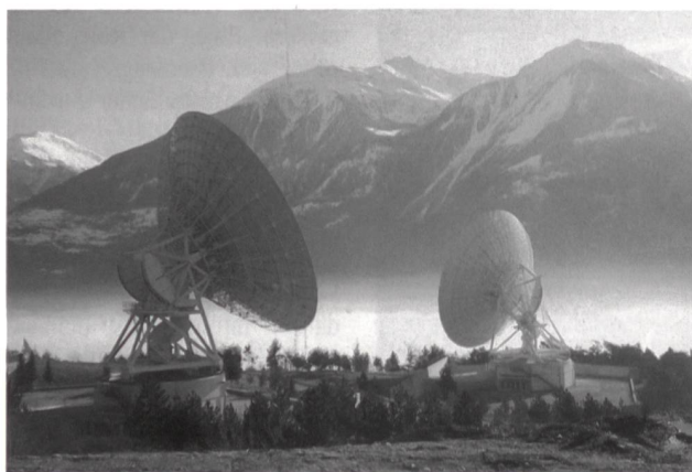
Position der Schweiz als Telekommunikationsland in Europa geschwächt? Im Bild eine Satelliten-Telekommunikationsanlage bei Leuk im Wallis (Photo K. Niederau).
