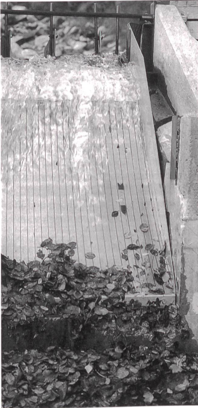
Bild 6 Laubanfall: der Rechen ist selbstreinigend.
