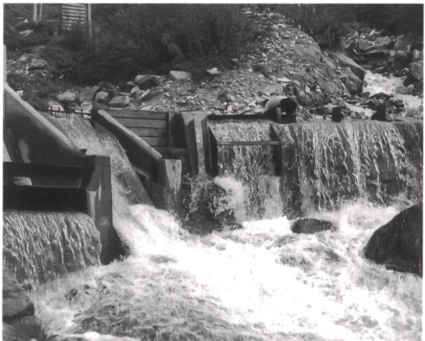
Bild 5 Pilotinstallation bei Hochwasser.
