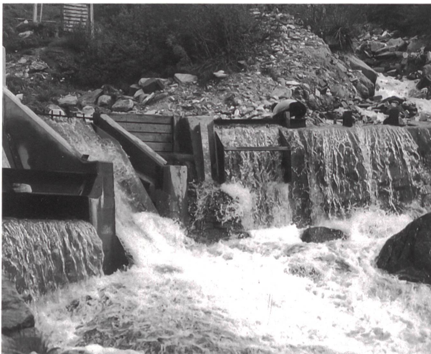
Bild 5 Pilotinstallation bei Hochwasser.
