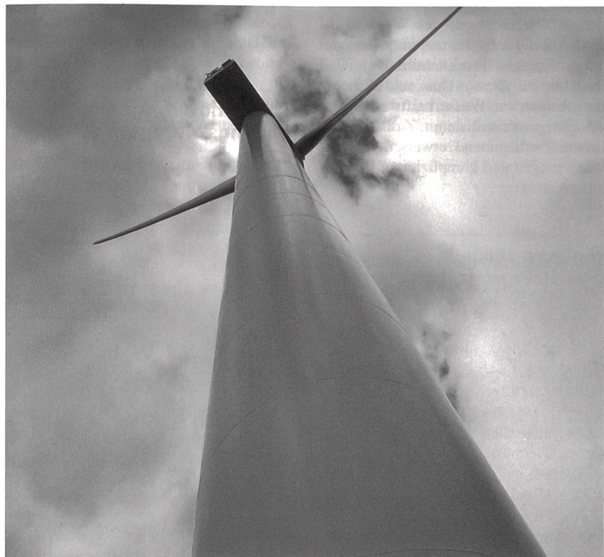
Nutzung der Windenergie weiter ausgebaut (Windturbinenrotor).
