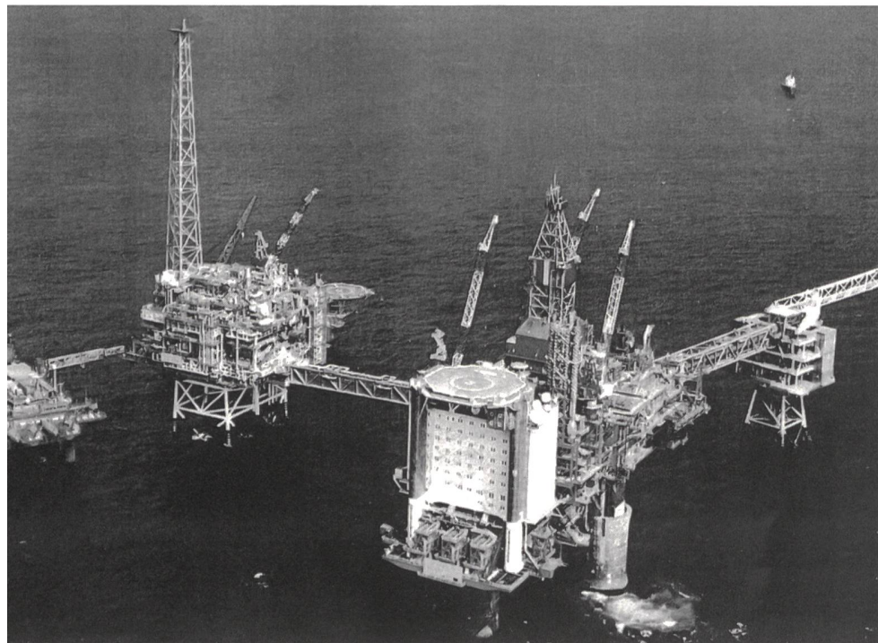
Bild 8 Kohlendioxid-Entsorgungsanlage auf einer Erdgasplattform in der Nordsee
