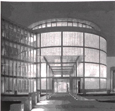
Im Lichterglanz: Neues Verwaltungsgebäude der Safe in Salzburg (Bild Safe).
