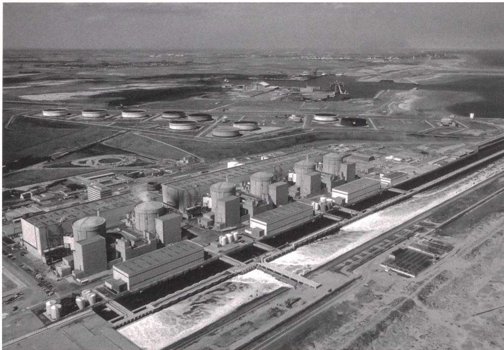
Kernkraftwerk Gravelines (Frankreich; Photo EDF).
