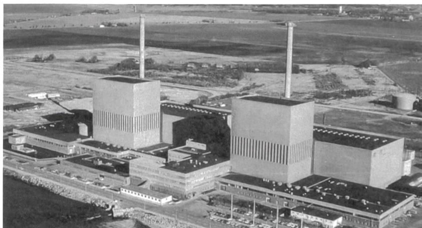
Kernkraftwerk Barsebäck (Schweden; Photo IZE).
