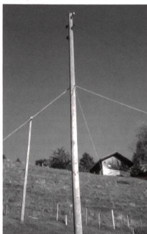
→ Das Besteigen von Holzmasten ist ohne entsprechende Sicherung verboten! Ein Holzmast ist gesichert durch beidseits festverbundene Leitung mit mindestens 8 mm Ø, gesichert durch Hebebühne oder durch geeignete Abstützung im oberen Drittel des Mastes.
