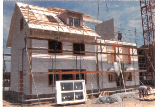
Bild 5 NOAH-Haus nach Minergie-Standard (Pilotanlage 1 «Grafstal» /ZH, erstellt durch Alfredo Piatti AG).
