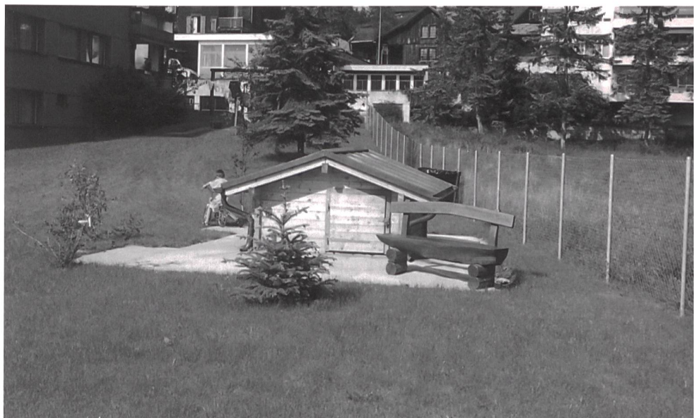
Bild 1 Heutiger Zustand des Bohrlochkopfes, als Chalet getarnt.
